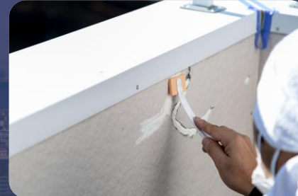
防水補修工事
