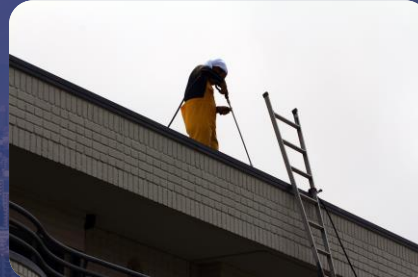
屋上塗装工事
